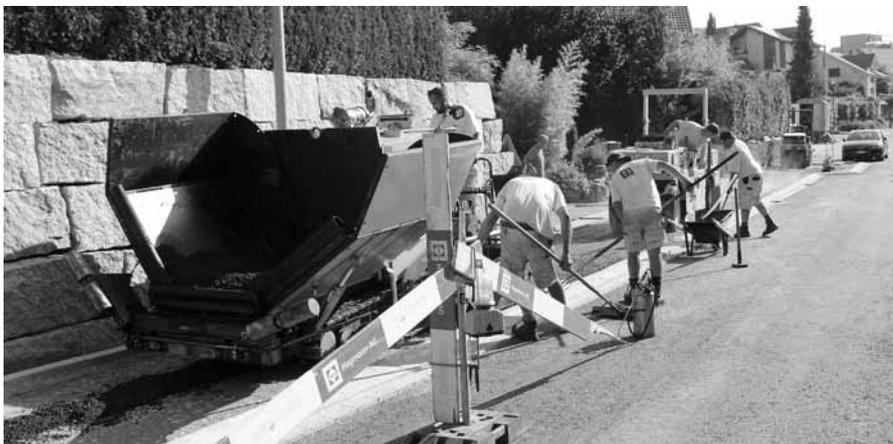
Die Bauarbeiten an der Lindastrasse sind auf der Zielgeraden. Diese Woche wurde während zwei Tagen beim Einlenker Lindau- / Buchenstrasse der neue Belag eingebaut. In den nächsten Tagen folgen noch Anpassungsarbeiten an den Vorplätzen. Im Sommer 2020 muss der Abschnitt für den Einbau des Deckbelags während drei Tagen vollständig gesperrt werden.
