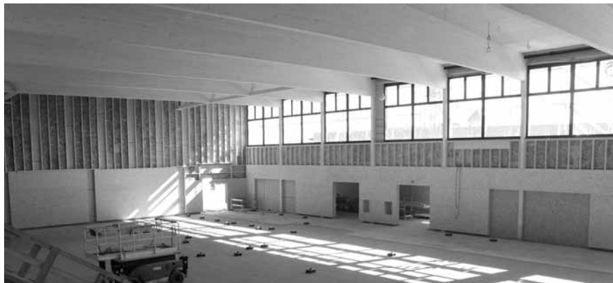
Beim Neubau der Dreifachturnhalle sind jeden Tag Baufortschritte ersichtlich.
