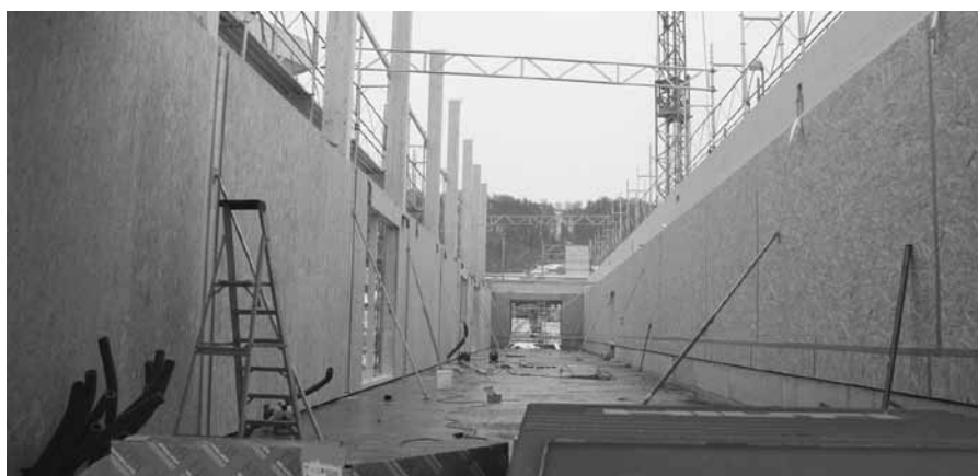
Der Geräteraum der neuen Dreifachturnhalle ist bereits gut ersichtlich.
