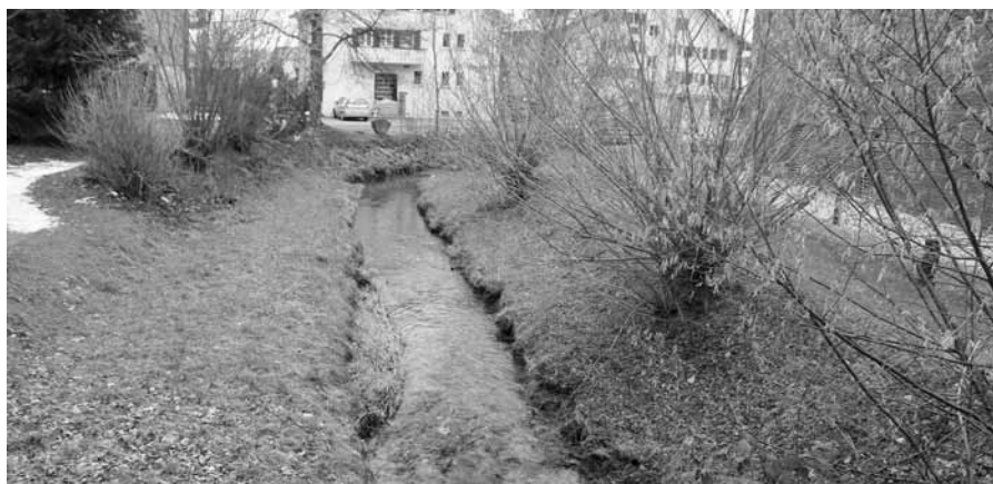
Am Dorfbach werden diverse Unterhaltsarbeiten, wie beispielsweise die Entfernung von Auflandungen oder Rückschnitte der Gehölze, durchgeführt.
