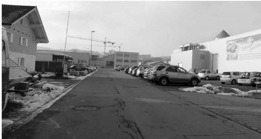
Die Industriestrasse «Nord» wird auf einer Länge von 200 Metern saniert.
