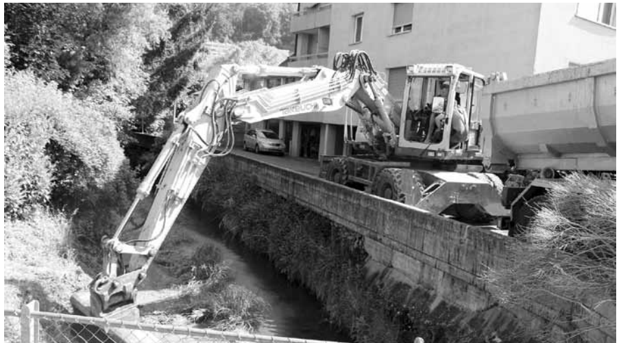
Im Mai dieses Jahres wurden Verlandungen aus dem Dorfbach entfernt. Dies waren ordentliche Unterhaltsarbeiten, welche jeweils losgelöst vom zu planenden Hochwasserschutzprojekt erfolgen.
