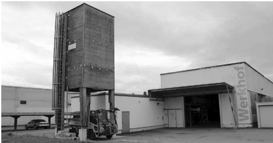
Der Werkhof an der Hinterdorfstrasse dient als «Ausgangspunkt» für die täglichen Arbeiten.
