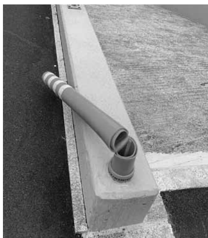
Beschädigter Markierungspfahl auf dem Schulareal
