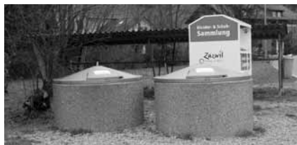
Auf dem Gemeindegebiet stehen 39 Unterflurbehälter.
