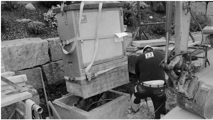
Auswechslung einer EW-Verteilkabine an der Lindastrasse.
