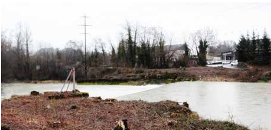
In diesem Bereich wird die neue Gillbrücke erstellt.
