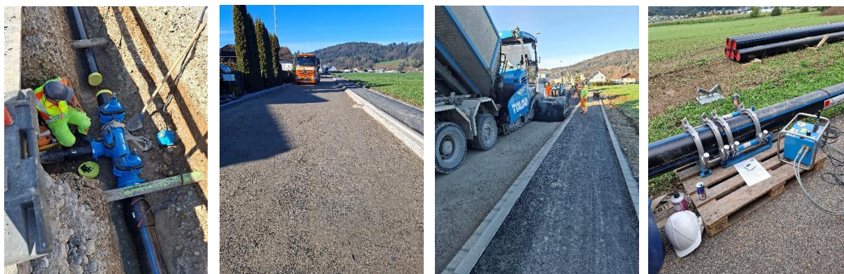
Abbildung 1: Baustelle Weierenstrasse in Züberwangen vom 02.09.2025
