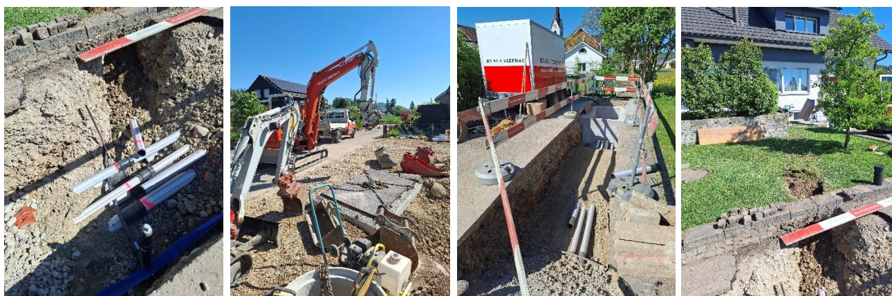
Abbildung 2: Baustelle Neufeldstrasse in Züberwangen vom 02.05.2025
