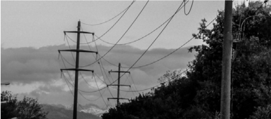
Das Strommesssystem wird bis zum Jahr 2029 vollständig ersetzt und an das Glasfasernetz angebunden.
