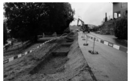
Die Arbeiten an der Weierenstrasse kommen gut voran.
