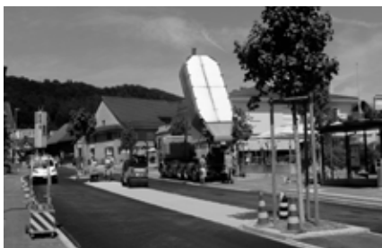
Die Arbeiten an der Mittel- und Unterdorfstrasse sind abgeschlossen.
