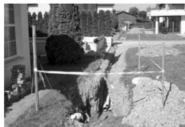
Sanierungsarbeiten für die Erneuerung der Erschliessung im Schulwiesenquartier
