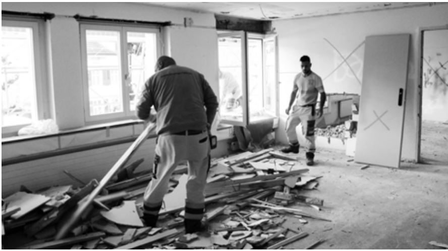
Ein Blick ins Innere des ersten Obergeschosses des Gemeindehauses zeigt die Baustelle.
