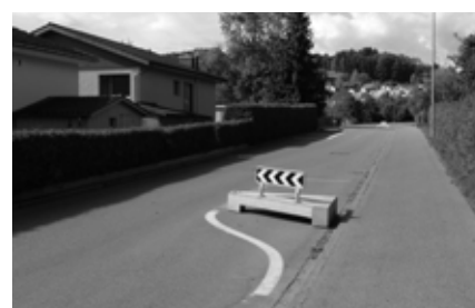
Betonelementen mit Abweisfeilen
