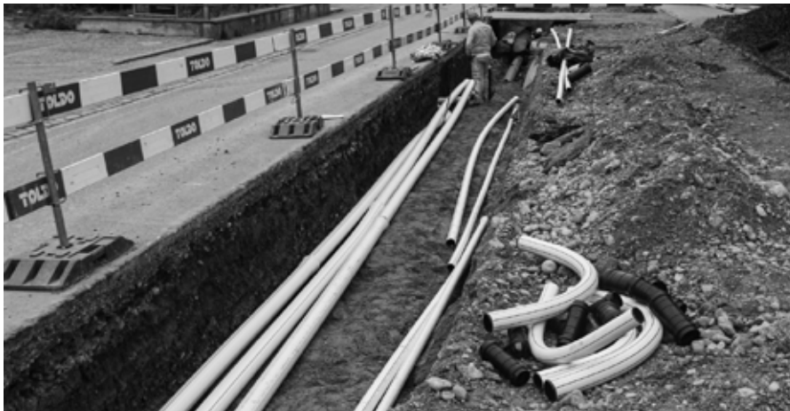
Derzeit werden in der Unterdorfstrasse neue EW-Leitungen eingebaut.
