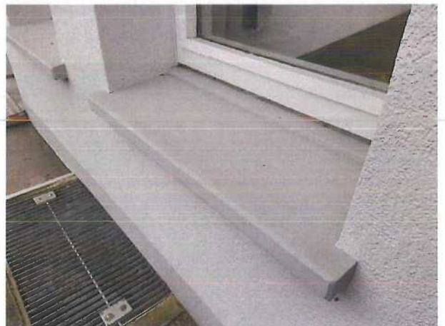
Fensterbank Stein, Altbau
