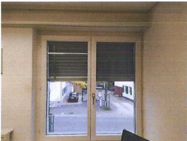
Fenster Altbau OG Süd, Rollladenkasten innen
