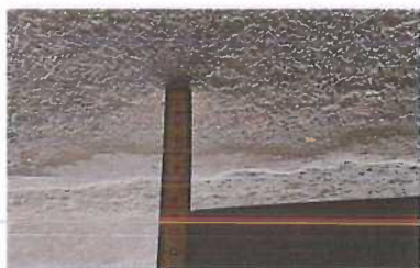
Decke Archiv im Altbau mit Hourdisdecke
