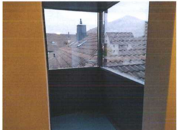
Verglasung gegen Süden beim Lift
