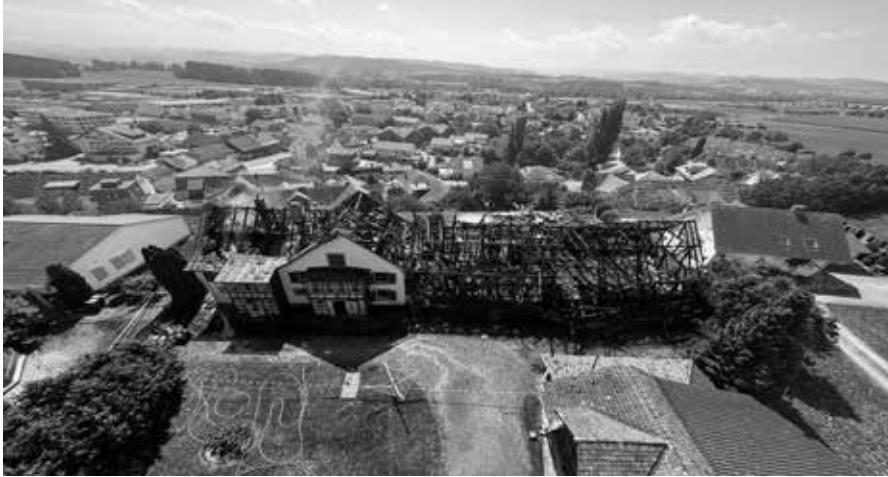
Mitte August des vergangenen Jahres brannte ein Wohnhaus mit Scheune an der Kirchstrasse ab. Der entstandene Sachschaden beläuft sich auf mehrere 100'000 Franken.
