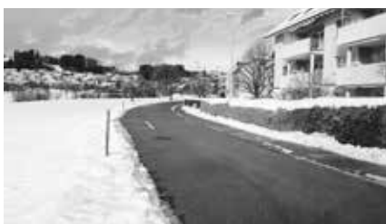
An der Tüfenwiesstrasse sollen bauliche Massnahmen zur Geschwindigkeitsreduktion geprüft werden.
