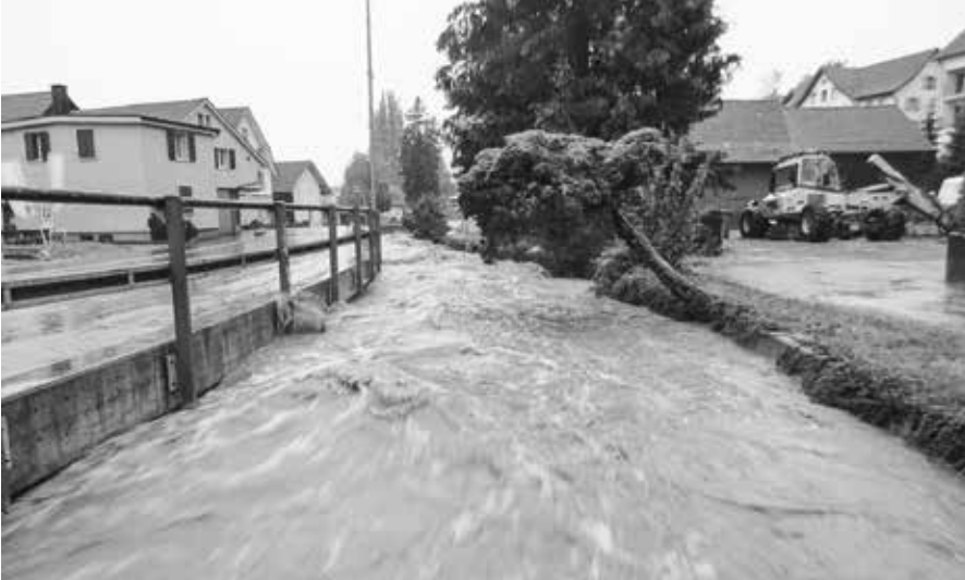
Der heutige Dorfbach stellt für die Gemeinde bei Starkniederschlägen eine potenzielle Gefahr im Dorfkern inklusive Schule und im Industriegebiet sowie in Weieren dar. Um die Sicherheit vor Hochwasser zu erhöhen, müssen bauliche Massnahmen getroffen werden.
