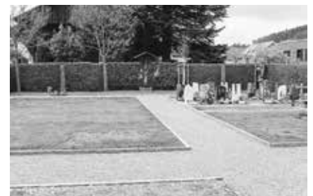
Die neuen Wege beim Friedhof in Züberwangen sind nun rollstuhlgängig.
