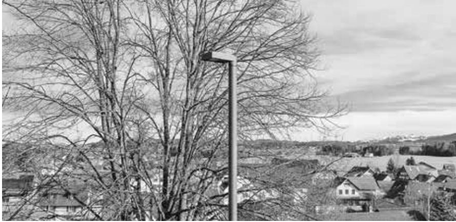
Rund 400 Strassenleuchten wurden bereits auf LED-Technik umgerüstet, weitere folgen.
