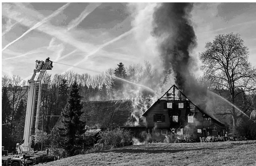
Vollbrand eines Einfamilienhauses in Niederglatt im April 2022.
