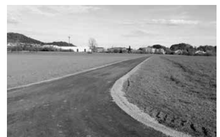
Neu ist die Feldhof- und Niederwiesenstrasse mit einem Hartbelag versehen.
