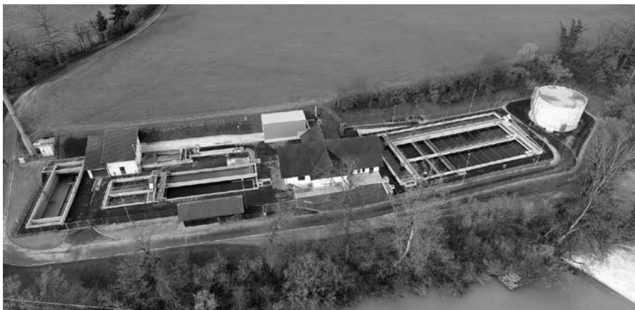
Die östlichen Becken der ARA Zuzwil werden auch mit der neuen ARA Thurau benötigt.
