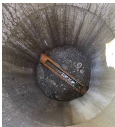
Abbildung 11: Bachunterquerung (Quelle: Schachtaufnahmen vom 24.06.2020)
