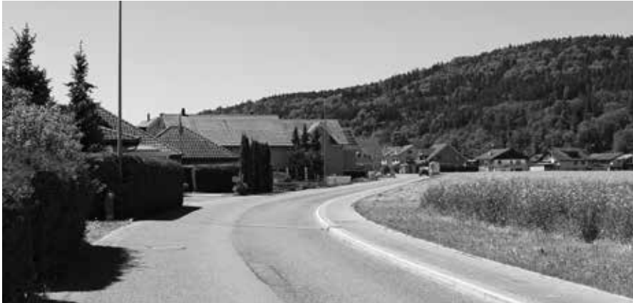
Das Trottoir ab dem Einlenker Feldhofstrasse bis zum Einlenker Schulstrasse wird anstelle der bisher geplanten 2m mit einer Breite von 1.75m durchgezogen.
