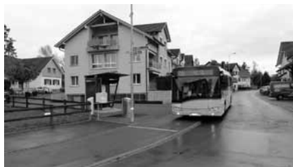
In Weieren werden die beiden Bushaltestellen ausgebaut.
