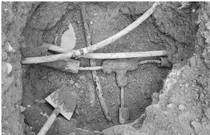
Ausführung von Tiefbauarbeiten für die Nachzugfähigkeit der Glasfaserkabel.
